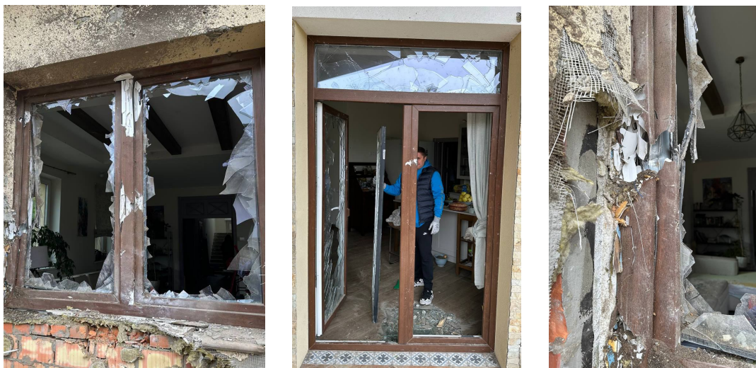
Рис. 1. Пошкодження вікон вибуховою хвилею та дрібними уламками, Київська обл., 2025 р. (фото Орленка М.О.)
