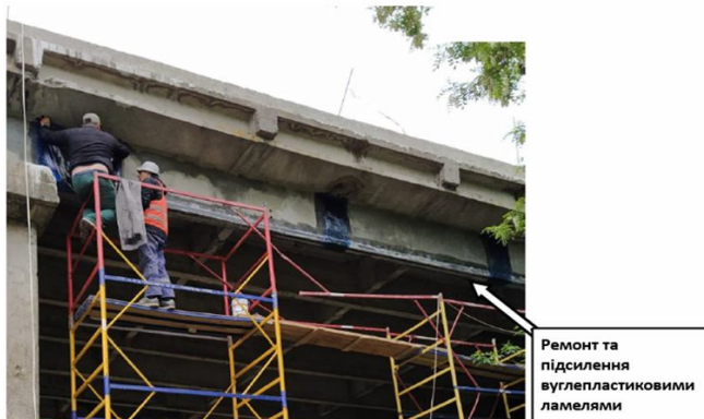
Рис. 1. Ремонт та підсилення прогонових будов шляхопроводу на км 219+400 а/д М-13 Кіровоград-Платаново. (фото: Т.Л. Чирва, ООО «Придніпров'я»)
