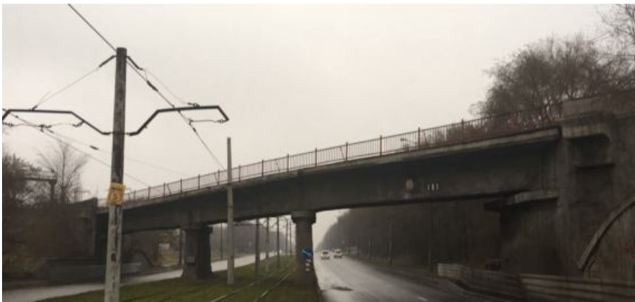
Рис. 3. Загальний вигляд шляхопроводу [1]
