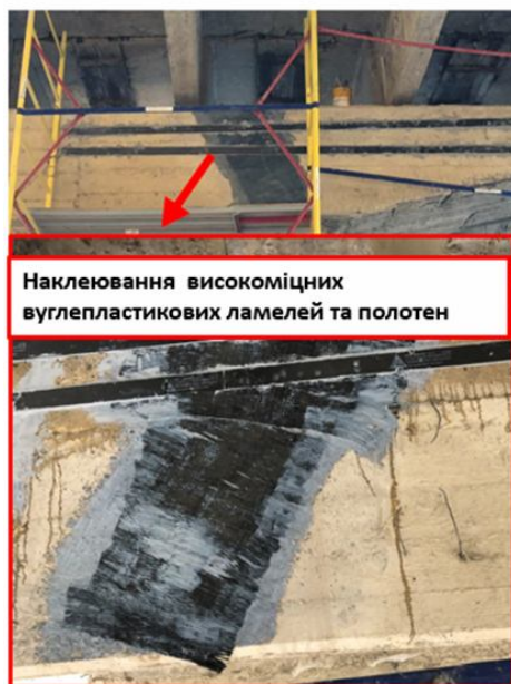
Рис. 2. Ремонт аварійного ригеля руслової опори мосту на км 106+976 автомобільної дороги Т-26-01 Чернівці - Вашківці – КПП". (фото В.М.Чирва, ООО «Придніпров'я»)
