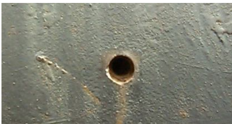
Рис. 2. Дренажний отвір багатошарової труби газопроводу діаметром 1420 мм
