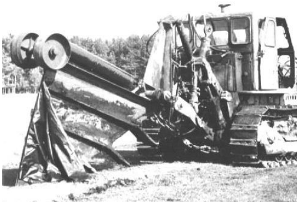
Рис. 7. Безтраншейний укладач рулонної полімерної плівки на глибину 1,5 м
