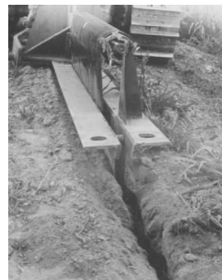
Рис. 8. Укладання рулонної плівки в основі земляної дамби
