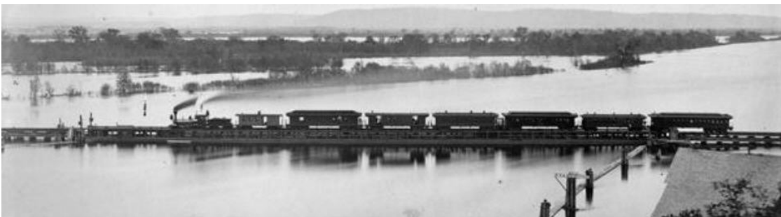
Рис. 7. Дерев'яний наплавний залізничний міст через р. Міссісіпі у Прейрі-дю-Шьєн (США) [3]
