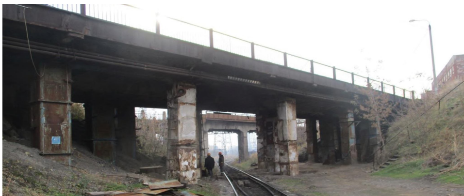
Рис. 1. Загальний вигляд стану шляхопроводу на період обстеження [4]
