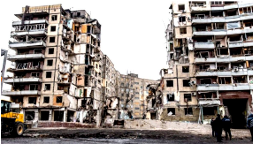
Рис. 7. Руйнування секції 9-ти поверхового панельного житлового будинку в результаті влучання російської ракети, м. Дніпро, 14 січня 2023 р.
