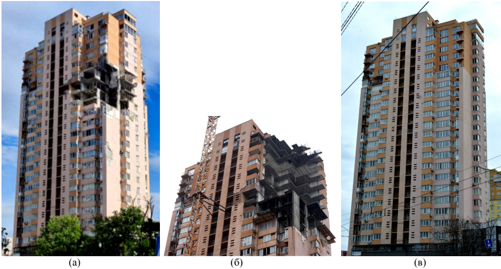
Рис. 6. Каркасно-монолітний житловий будинок, м. Київ: a – руйнування від влучання російської ракети лютого 2022 р.; б – демонтаж конструкцій 17...26 поверхів; в – відновлений будинок
